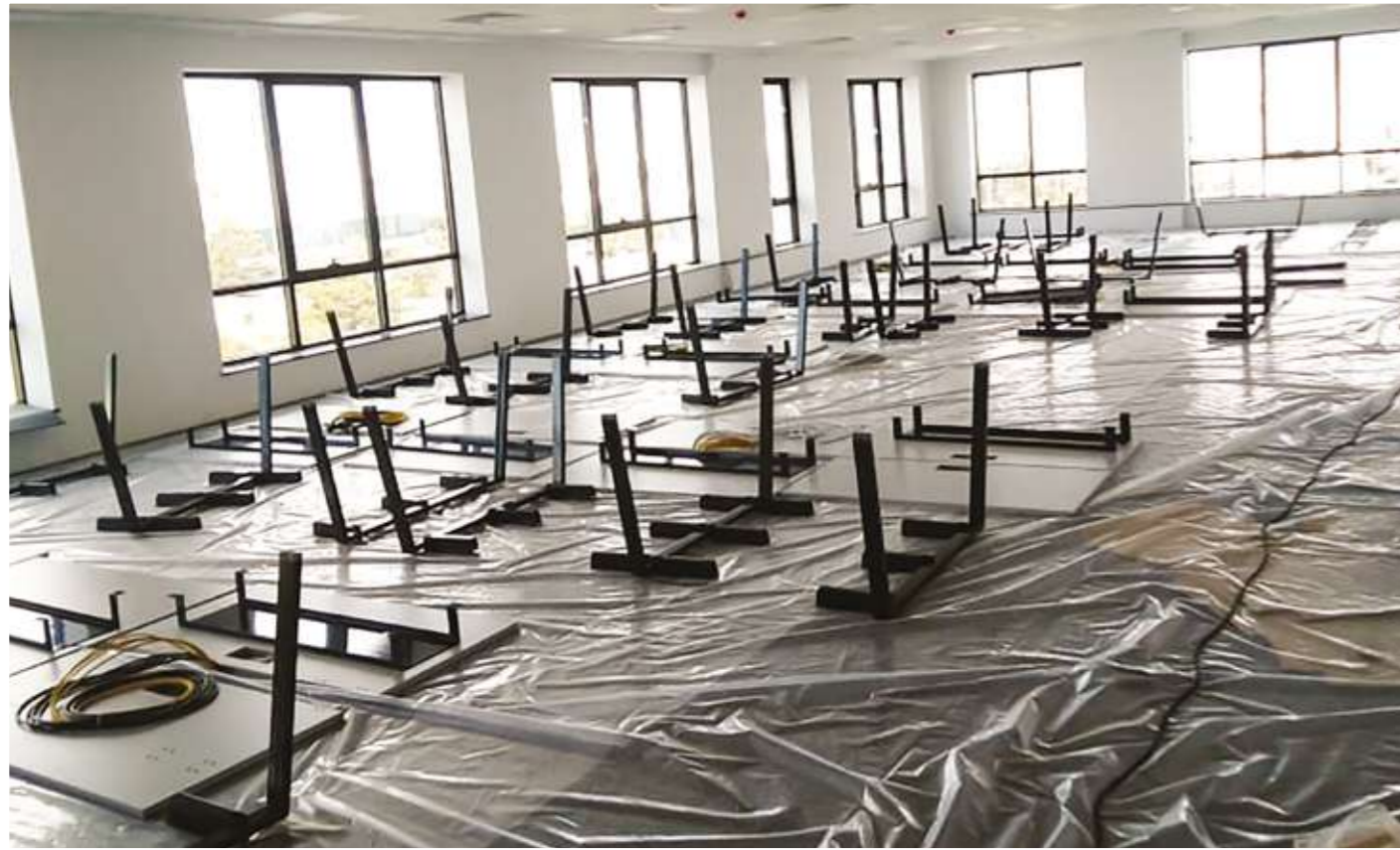
Installation des bureaux Bench Isocèle dans l'open-space
